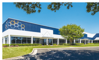
米国の細胞製品製造施設の建設予定地 (ノースカロライナ州ダーラム近郊) (総投資額：約$34M、延床面積：3,385m 2 )
