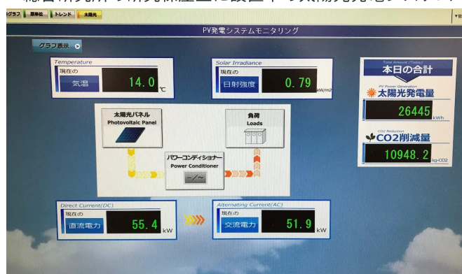
太陽光発電量を研究所内のモニターに随時案内
