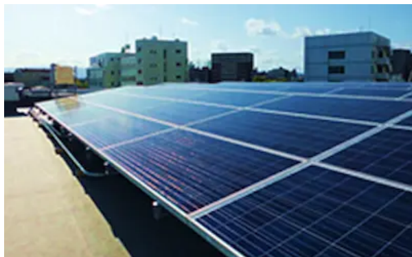
総合研究所の研究棟屋上に設置中の太陽光発電システム
